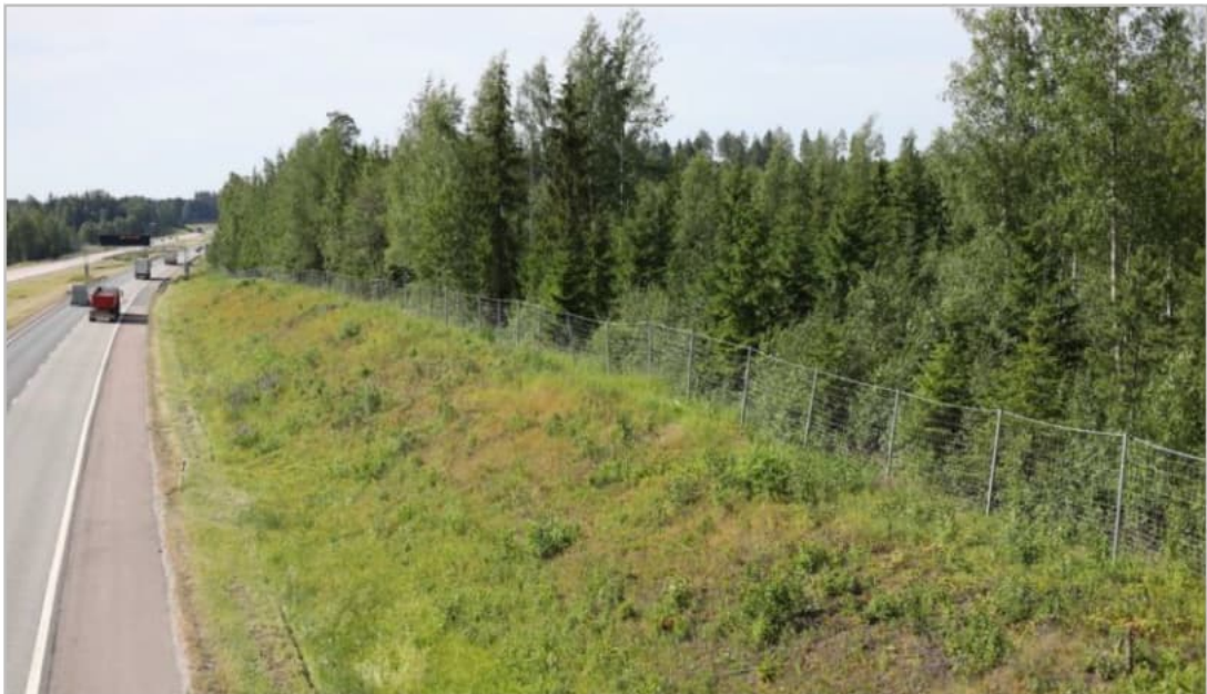
Kuva 69. Ilvesvuorta sivuavalla suoralla osuudella hankealue on jyrkän moottoritien luiskan ja loivan kaarteeseen takia juuri hankealueen kohdalla nähtävissä heikommin kuin etäämmältä. Kuva Aspinniituntieltä.
