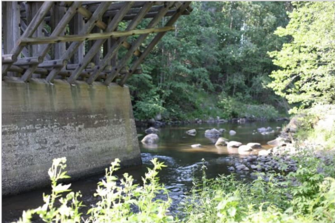
Kuva 58. Näkymä Myllysillan alapuolelta yläjuoksulle päin, kohti hankealuetta. (Kuva © Sitowise Oy).
